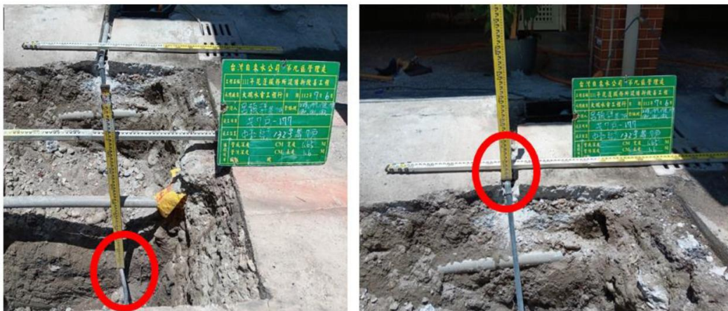
圖 13 用戶接管之埋深量測位置示意圖
